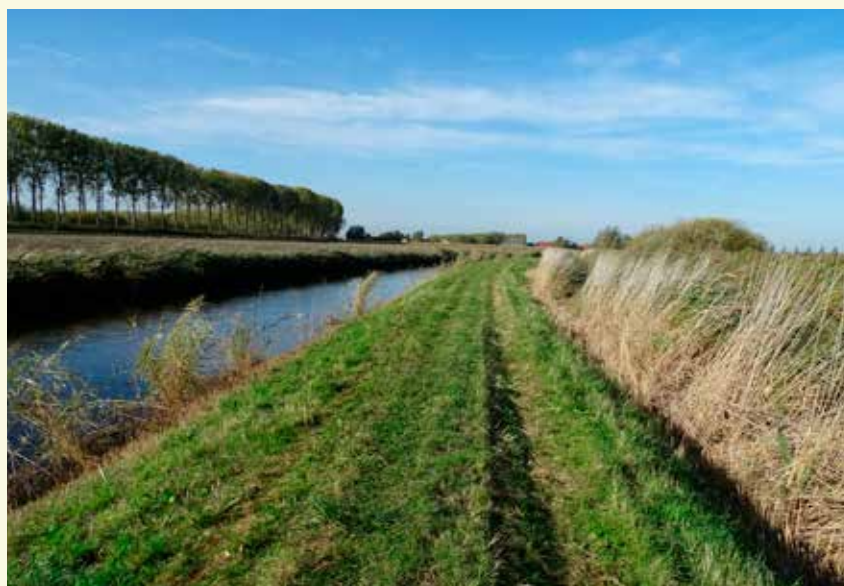
Een mooi stukje langs het Leopoldkanaal, tussen Stenenschuurbrug en Oesterputbrug
