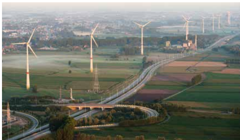
Lijninfrastructuren zoals de E34 zijn erg geschikt voor turbines (foto: Ludo Goossens)
